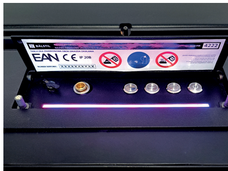
Rys. 9-5 Urządzenie w trakcie uruchamiania i testu podzespołów
